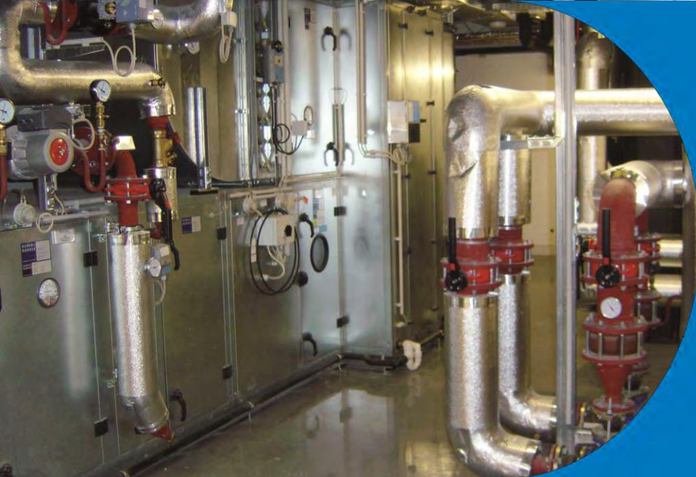
Generell wird die Zuluft in den Aufenthaltsbereich eingeblasen mittels Anemostaten, Drallauslässen und über Gitter an der Decke abgesaugt. Das GMP und die Sterillabors erhalten Absolutfilter vor den Auslass. Die Luftverteilung und Absaugung erfolgt über verzinkte Stahlblechkanäle gemäß ÖNORM H 6015.
